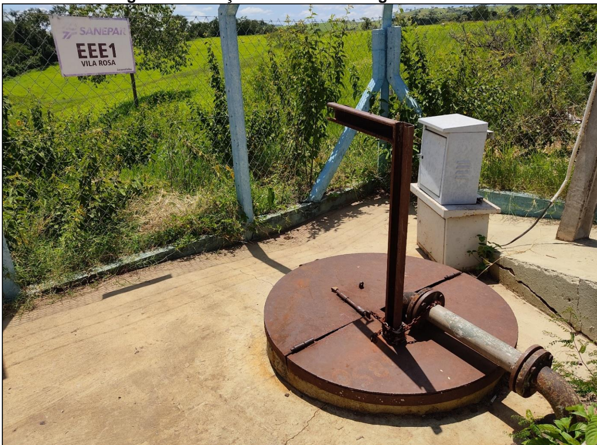
Figura 30: Estação Elevatória de Esgoto Vila Rosa.
