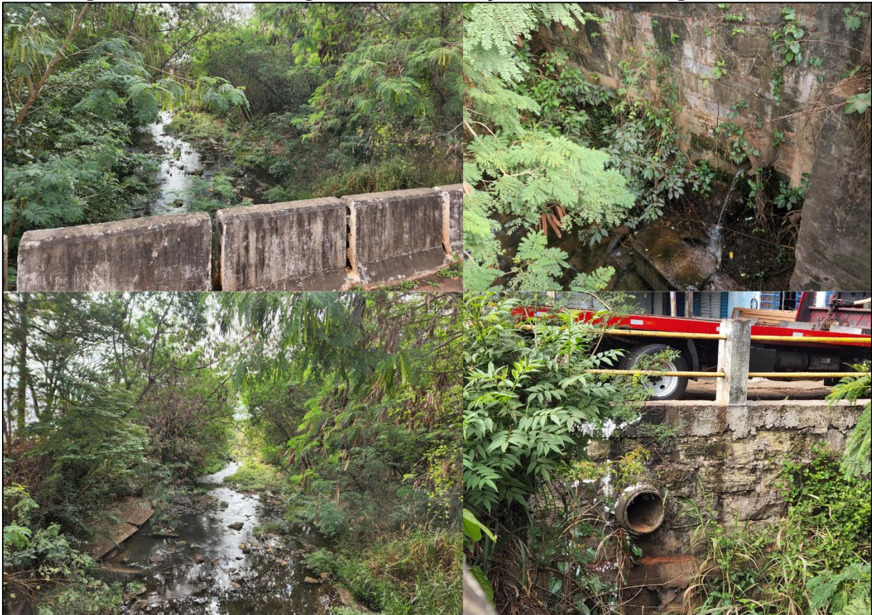
Figura 57: Macrodrenagem urbana e lançamento de drenagem urbana.
