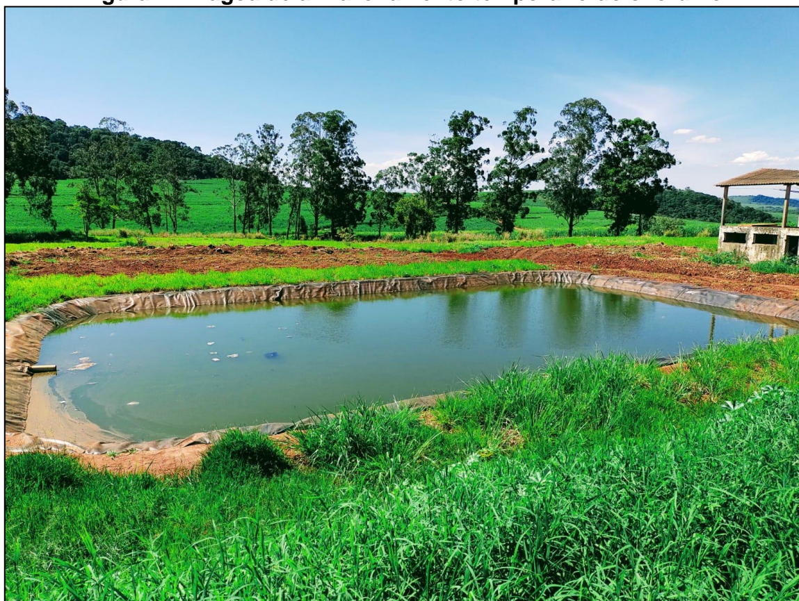
Figura 41: Lagoa de armazenamento temporário do chorume.
