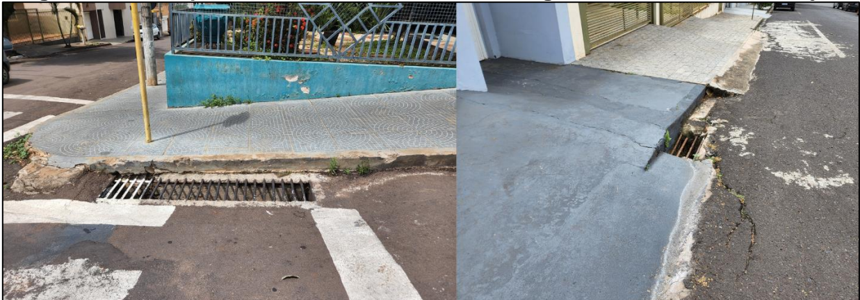
Figura 56: Exemplos de estruturas de microdrenagem – boca-de-lobo e sarjeta.
